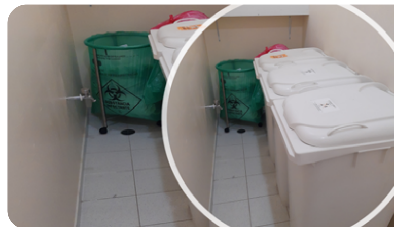
ABRIGO TEMPORÁRIO DOS RESÍDUOS NAS INSTALAÇÕES DA UHHS, DE SÃO PAULO, CONFORME O PGRSS.
